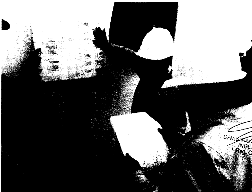
Fotografía N°06: Vista de inspección de trabajos eléctricos por parte de especialista de la supervisión.
